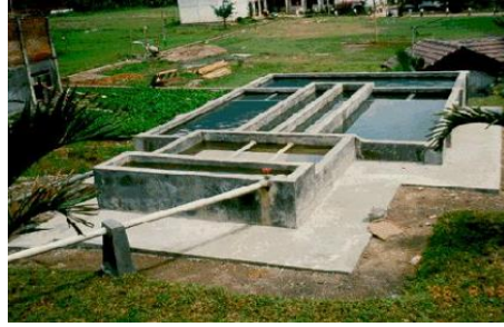
Gambar 11. 3. Teknologi saringan pasir lambat dengan kapasitas 100 m 3 /hari (Sumber: Herlambang; 2010)
